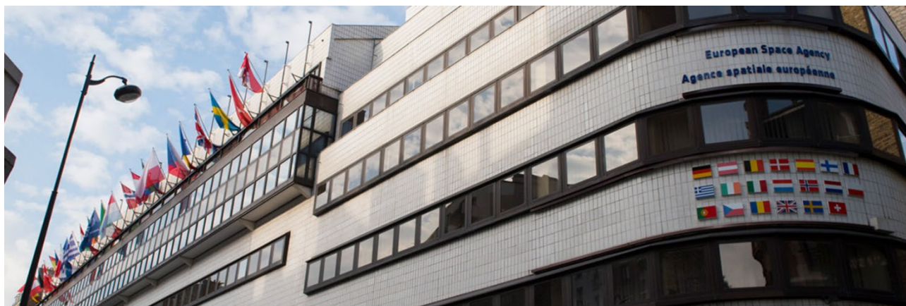
Kuva 27. ESAn pääkonttori ennen 2020-luvun remonttia.
